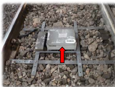
Antenne au sol pour la localisation du matériel en terminus « SEMR »
